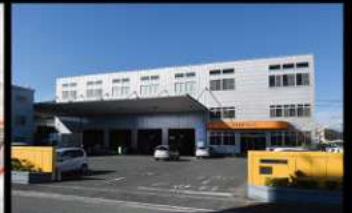
▲本社内屋外観
