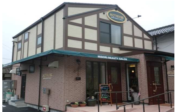
おしゃれな店舗外観。玄関前には車いす専用スロープも完備。
